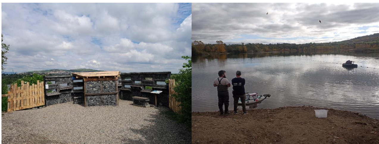
Photo 10 : réparation de l’observatoire des Varennes et de la ligne d’eau de la zone de pêche
