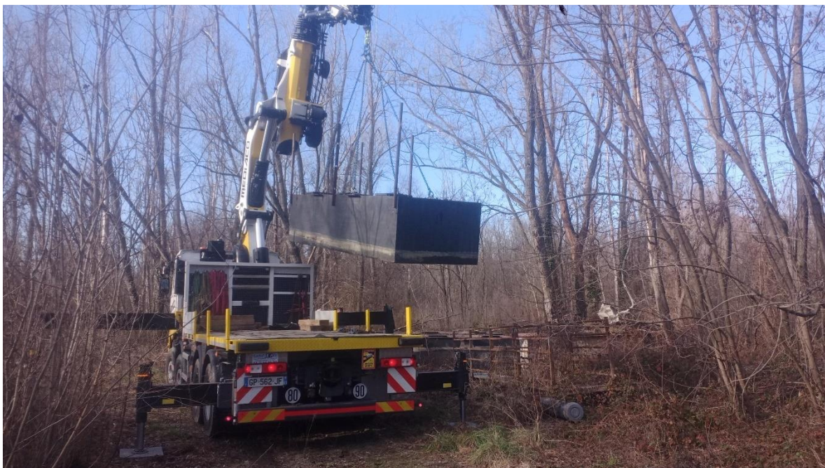
Retrait de déchets métalliques dans une mare sur le site de l'Ecopôle.
