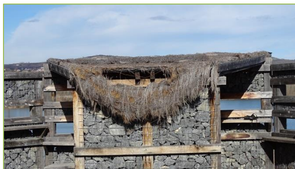
Photo 6. Reprise du toit de l'observatoire de Varennes
