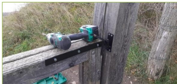
Photo 6. Réparation de la charnière de la barrière de Varennes
