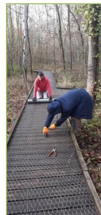
Photo 1. Mise en place du grillage sur le platelage de la Montagne
