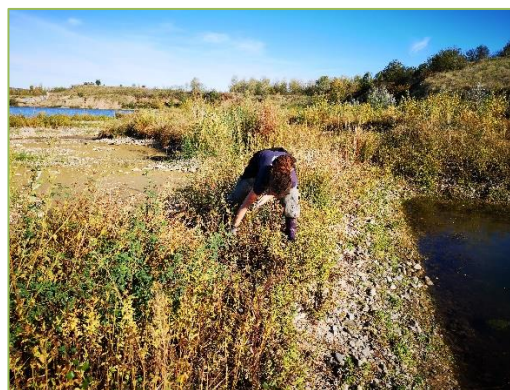
Photo 2. Arrachage des ligneux sur les digues de Varennes
