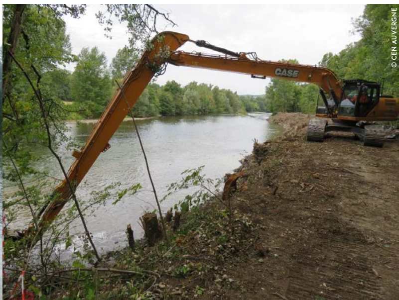
Enlèvement des enrochements les plus éloignés avec la pelle à bras long
