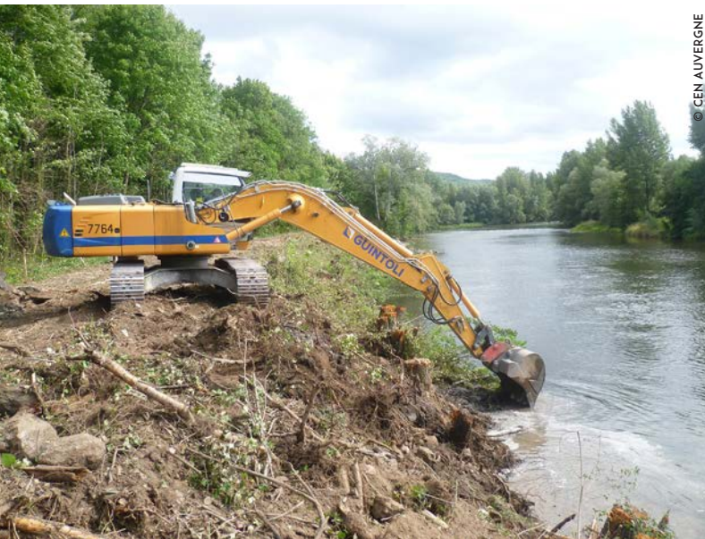
Enlèvement de la protection de berge
