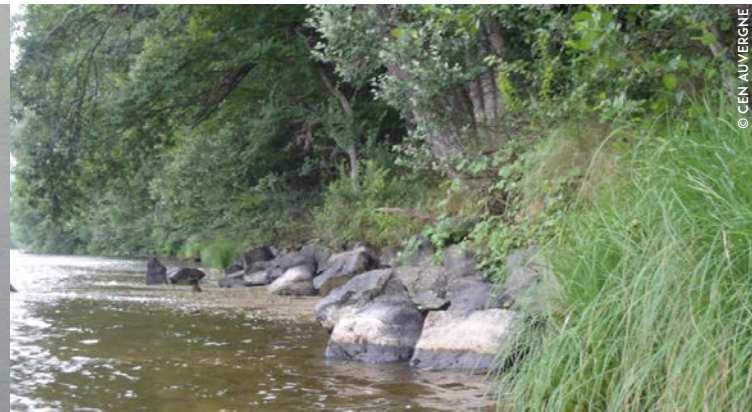
Enrochement avant travaux
